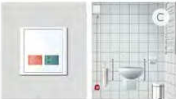
Zugtaster zur Spritzwasser geschützten Rufauflösung und Abstelltaete zur Quittierung von Rufen aus der Nasszelle.
