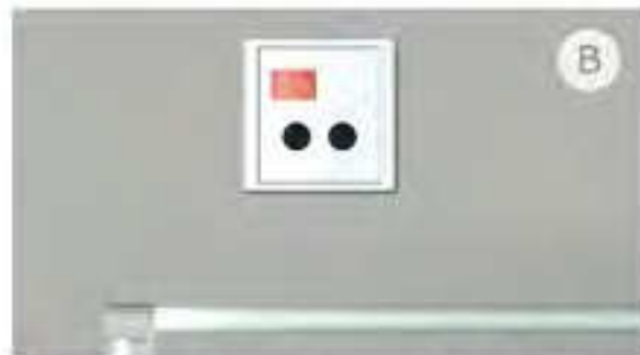
Rufeinheit mit Nebensteckkontakten für sowohl für den Anschluss von mobilen Rufeinheiten, Birtastern u ä sowie Buchse zum Anschluss und deduzierter Rufauflösung von medizinischen Geräten (Perfusor, Monitor u.a.)
