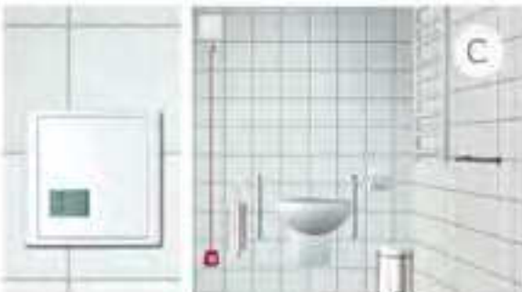
Zugtaster zur spritzwassergeschützten Rufauslösung und Abstellaste zur Quittierung von Rufen aus der Nasszelle.
