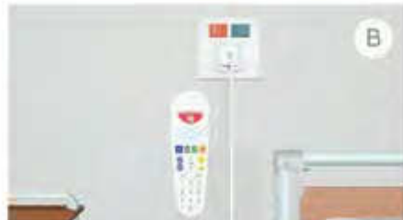
Wandmodul LAN und integriertes Patientenhandgerät mit Steuerungs-, Telefon- und Abrechnungsfunktionen sowie optionaler Rufbearbeitung über mobile DECT-Endgeräte.
