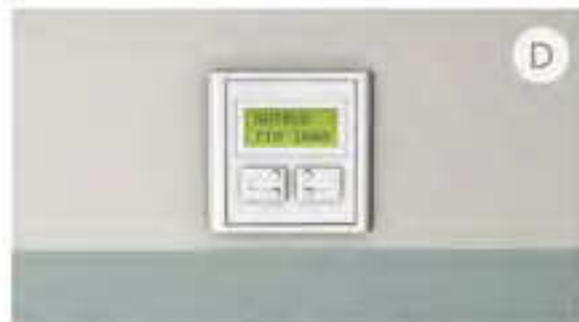
Universaldisplay als programmierbare und dienstabhängige parallele Anzeigeeinheit für Rufe und Alarime.
