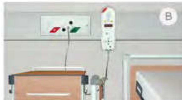
Battemodul als multifunktionale Schnittstelle zu einfachen und integrierten Patienten- Bediengeräten ermöglichen die einfache Steuerung von ELA, Patienten-TV, und Raumsteuerung (Licht, Jalousie ...) sowie der diskreten Pflegekommunikation.
