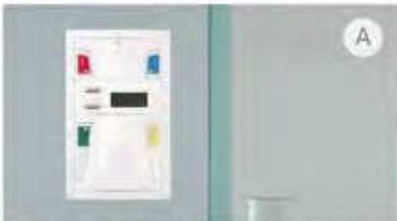
Zimmerterminal als Kommunikations-, Anzeige- und Bedieneinheit für den Pflegedienst ermöglicht zusätzlich zu den standard Lichtrufaktionen, mehrere programmierbare Ruf- und Anwesenheitskreise und digitale Sprachfunktionen wie Nebenabfrage und Personalsprechen.
