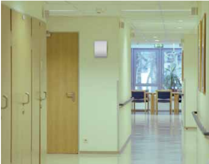
Unauffällige Patienten-Transponder werden von der Sende-/Empfangeinheit im Türbereich sicher ermittelt.
